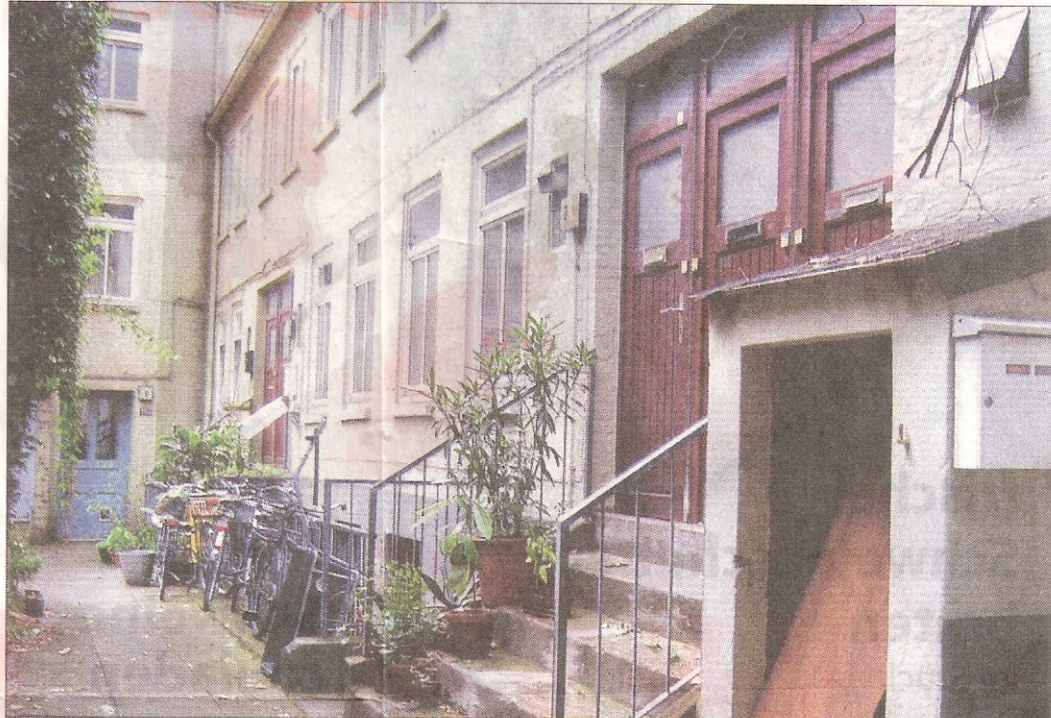
Die Elbtreppehäuser sind gerettet.
